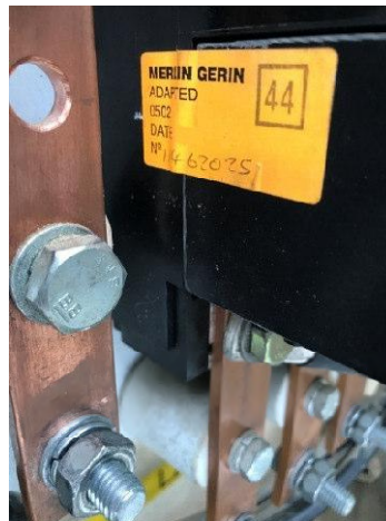
Direktanschluss auf Schiene: Max. 240 2 - M12 Kabelschuh
