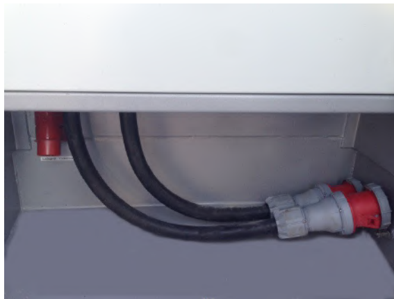
2 x 125A – 5 pol. CEE + Spannungsversorgung
