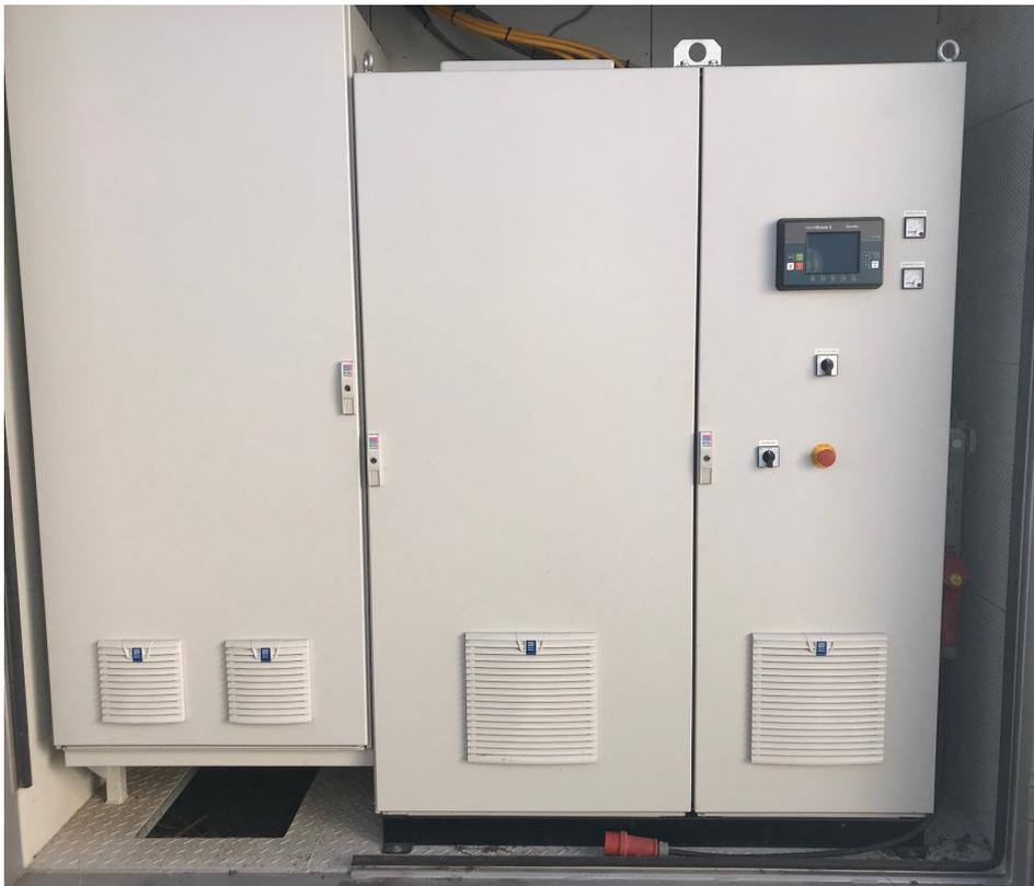
eingebaut in einem eigenen Schaltraum , der seitlich im Container angeordnet ist und über eine eigene Eingangstür erreichbar ist.
