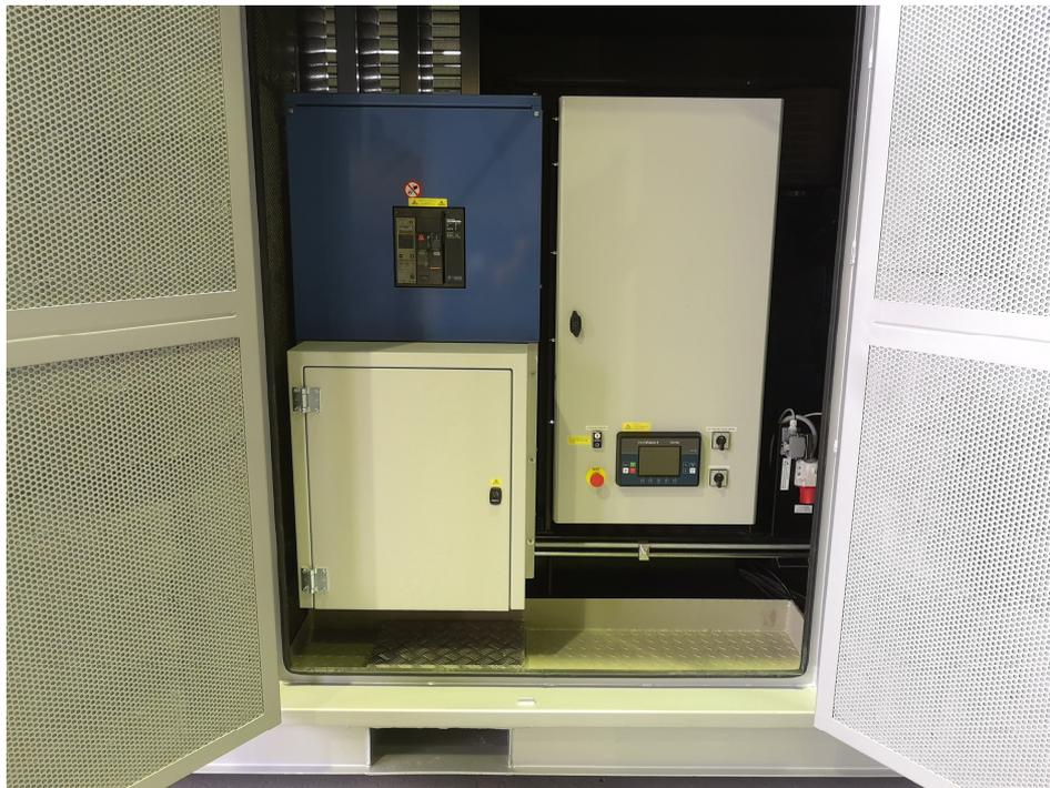
eingebaut in einem eigenen Schaltraum, der seitlich im Container angeordnet ist und über eine eigene Eingangstür erreichbar ist.
